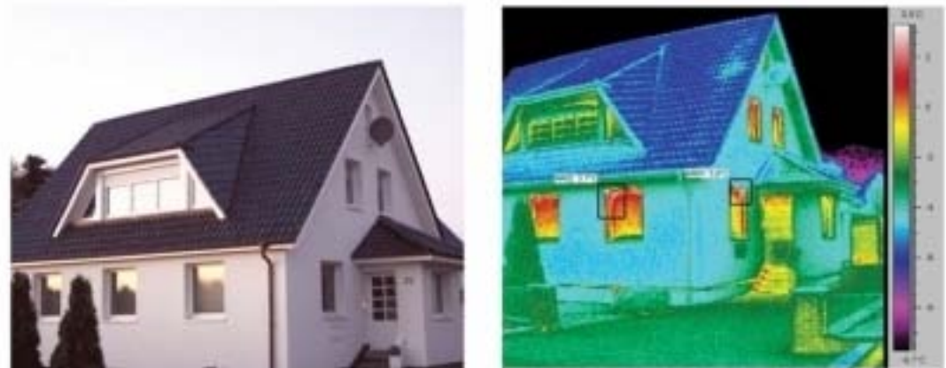
Zustand dieses Hauses n a c h der Sanierung
